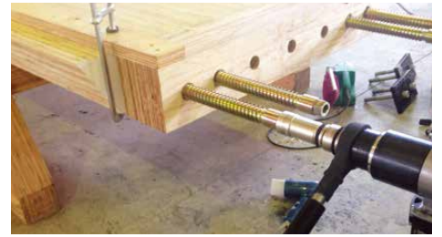
ラグスクリューボルト打ち込み
